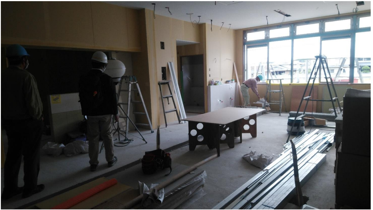
ユニバーサルカフェ・福祉避難所スペース
