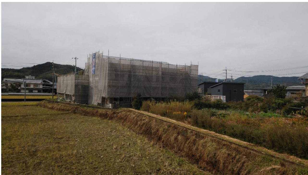
全景（東側より）
