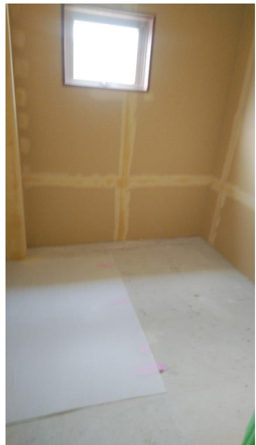
多機能トイレスペース
