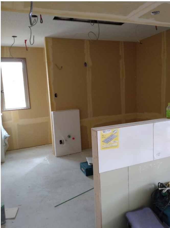
ユニバーサルカフェ・福祉避難所 のキッチンスペース
