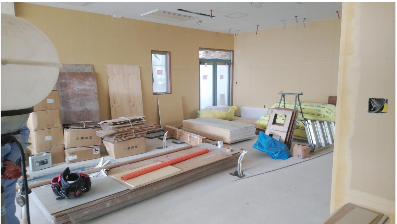
ユニバーサルカフェ・福祉避難所スペース
